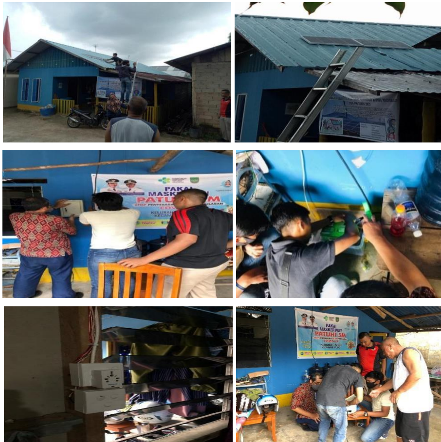
Fugur 6. Proses Pemasangan Sistem PLTS di Rumah Ketua RT
