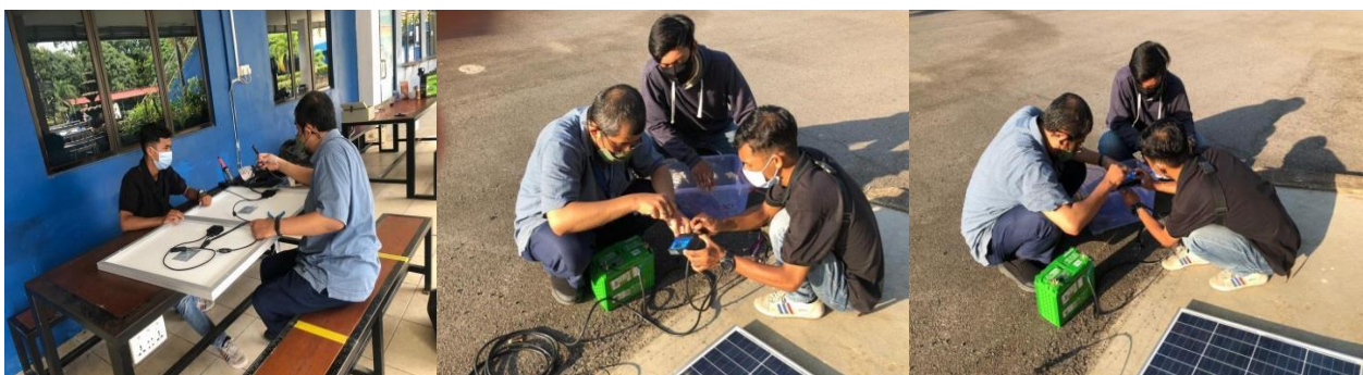
Figur 4. Perakitan PLTS dengan panel surya, SCC dan baterai
