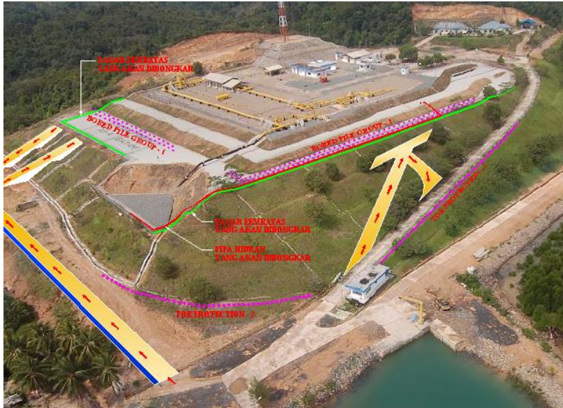
Gambar 1. Area Pengecoran Tiang Bor
