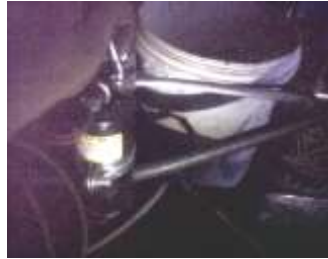
Gambar 8 Pemasangan hose dan pipa liquid
