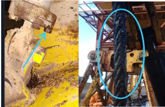
Gambar 4. Jenis kerusakan oli bocor (kiri) dan wire rope terkikis (kanan)
