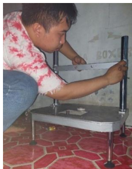
Gambar 10. Pemasangan Frame Bearing Pada Tiang
