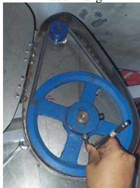
Gambar 11. Pemasangan Sistem Transmisi
