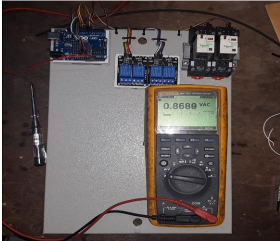
Gambar 14 Pengukuran dengan Multimeter
