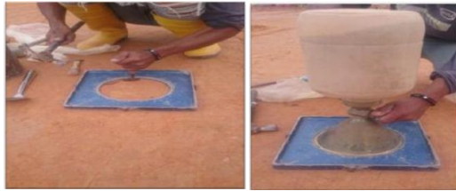
Gambar 4. Pengujian sand cone di lapangan
