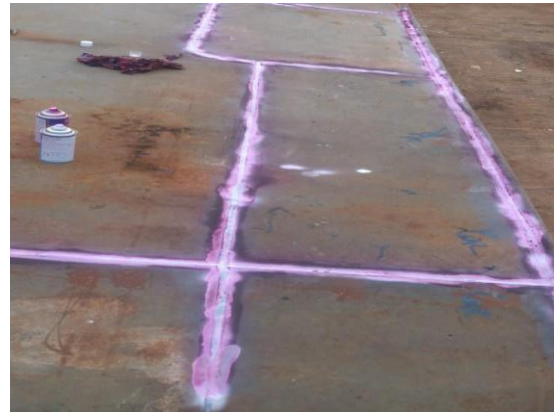
Gambar 21. Proses pengujian penetran test
