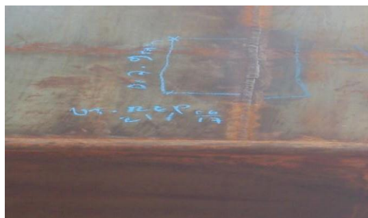
Gambar 24. Failed hasil pengujian UT bagian ekor kapal.
