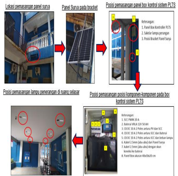
Gambar 7. Pemasangan dari PLTS dan beban lampu penerangan
