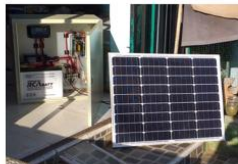
Gambar 11 Dokumentasi Perakitan Solar Cell
