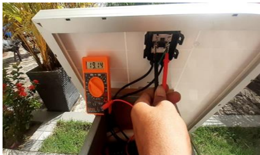
Gambar 4.2 Pengukuran Solar Panel
