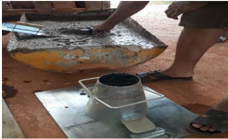
Gambar 3. Proses Penuangan Adukan
