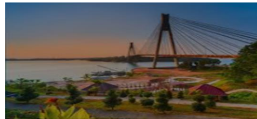
Gambar 1. Jembatan 1 (jembatan fisabilillah)
