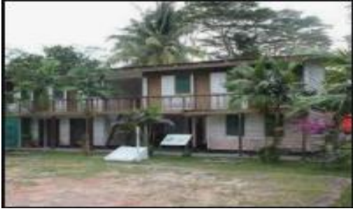
Gambar 4. Bangunan Kampung Vietnam
