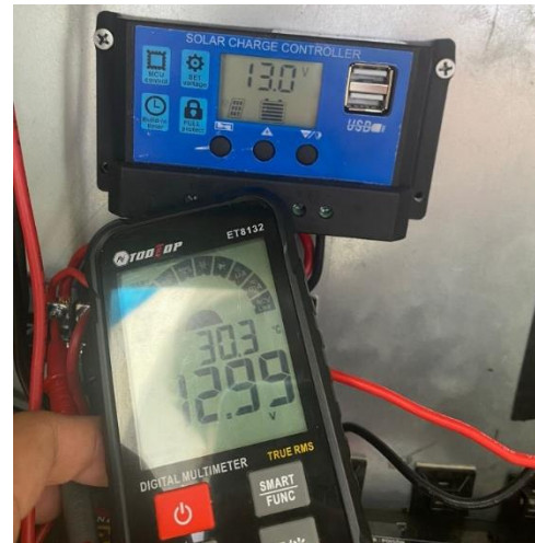
Gambar 17. Pengukuran tegangan Kemudian setelah mengukur tegangan pada solar panel. Maka dilanjutkan dengan mengukur arus pada solar panel, seperti pada gambar berikut ini
