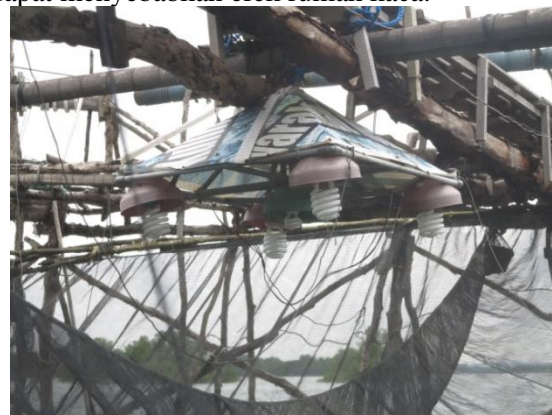
Gambar 1. Sistem Penerangan di Keramba Cahaya yang berasal dari lampu petromak tidak optimal karena posisi lampu yang dipasang pada titik-titik simetris keramba membuat cahaya lampu menyebar ke arah luar. Hal ini tentu
